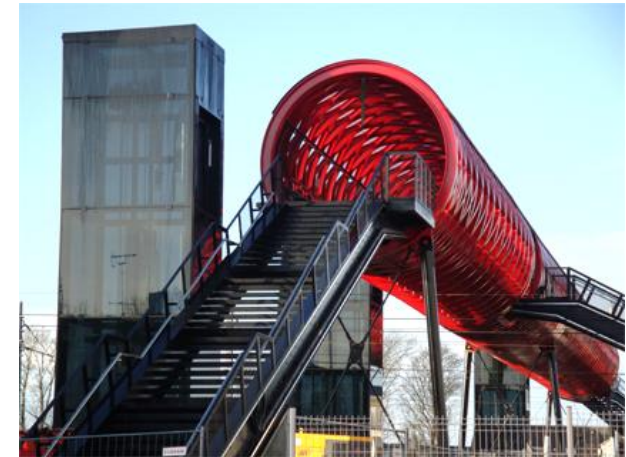
Nouvelle passerelle enjambant les voies
