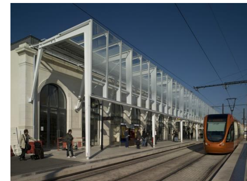
Parvis de la Gare Nord après la mise en service du tramway
