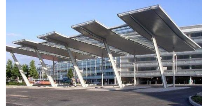
Quais de la nouvelle gare routière réalisés lors de la phase 2
